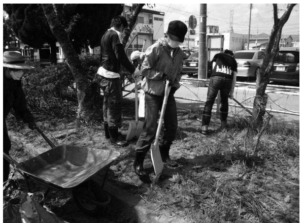
重機が入れない植込部分の草を刈った後、 汚泥をスコップで取り除き、一輪車で運ぶ。
