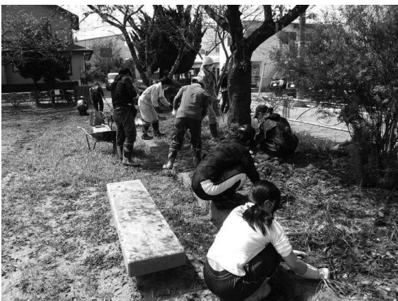
今回の作業は、堆積した汚泥を撤去すること。 震災から4ヶ月経ち雑草もかなり生えた状態 でした。
